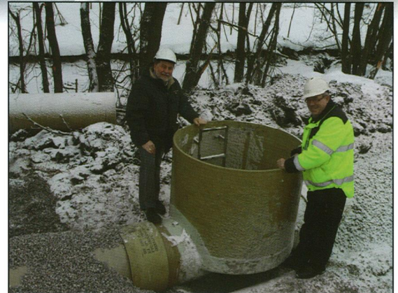
Lange rørgater fanger opp overflatevann og forurenset bunnvann fra det enorme deponiet som dekker 400 mål på Øra i Fredrikstad. Kai Gabrielsen fra BD (til venstre) har overvåket rørleveringene til Frevars Tor Fagermoen.
